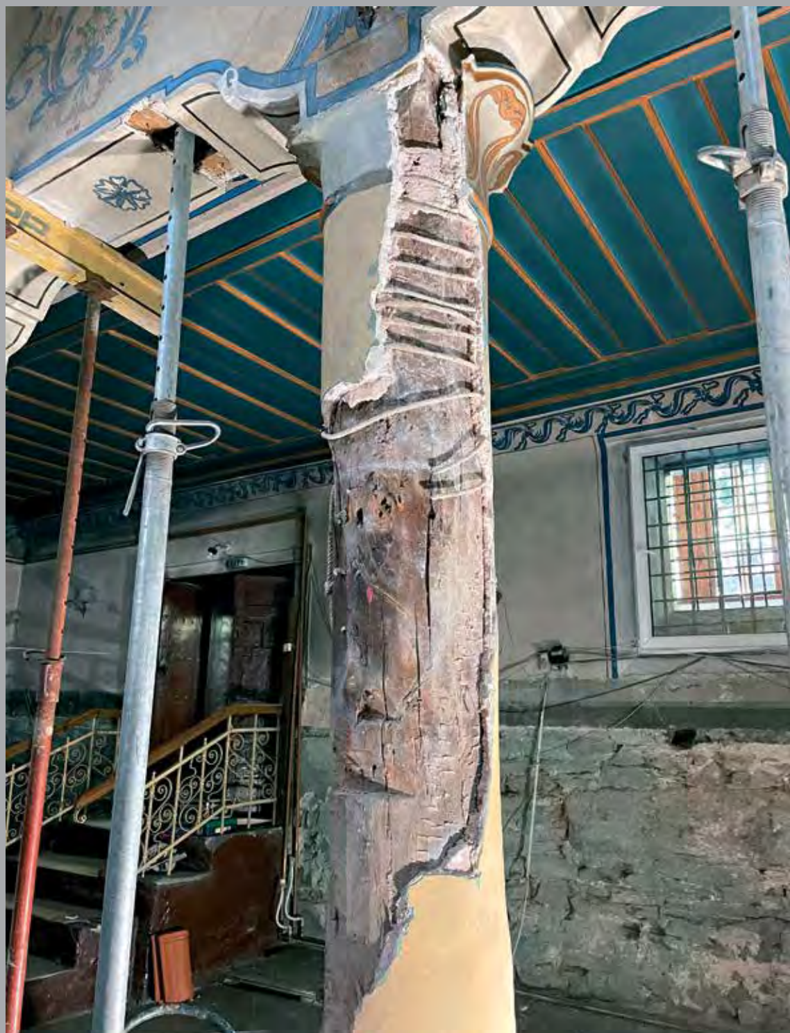
ФИГ. 1. Сондажи за установяване на техническите характеристики и състоянието на носещите колони
